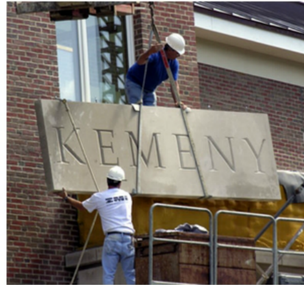
5. A Kemény Hall építése
