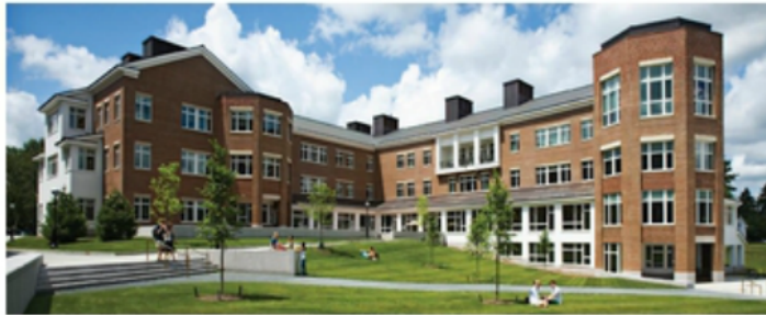
4. A Kemény Hall keleti homlokzata Dartmouth-ban
